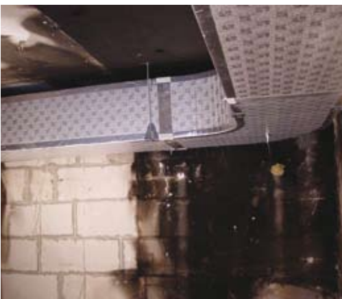
Fig. 11 - Instalación del conducto en aluminio pre-aislado P3ductal
