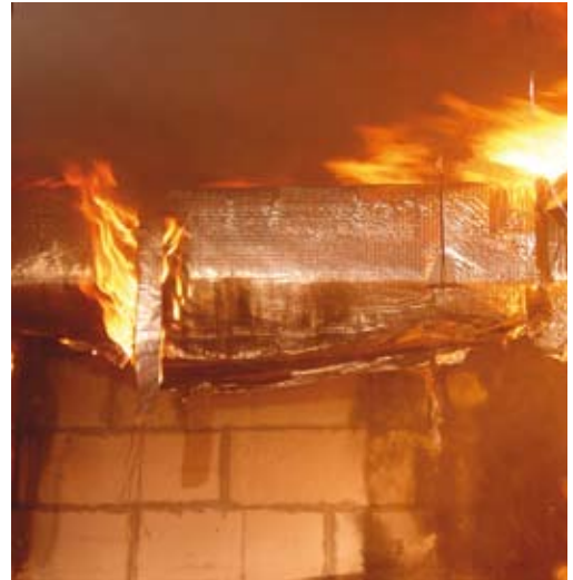
Fig. 17 - El conducto en chapa muestra una importante participación en la difusión del incendio
