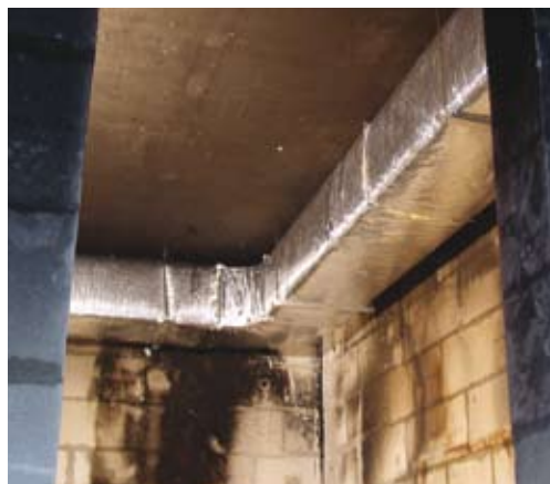
Fig. 12 - Instalación del canal en chapa galvanizada revestida con lana de vidrio
