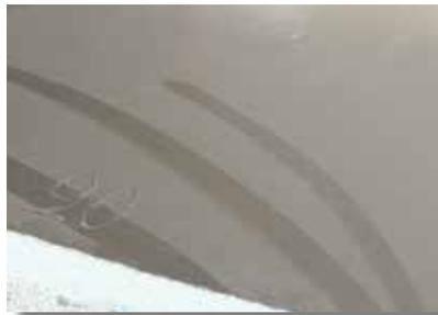
*Detalle del polvo depositado adentro de un conducto P3ductal indoor liso almacenado en la obra*
