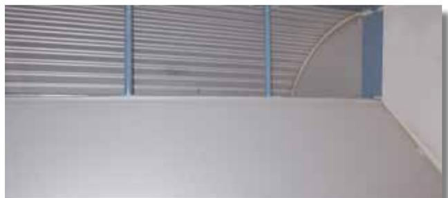
*Detalle del polvo depositado adentro de un conducto P3ductal careplus almacenado en la obra*
