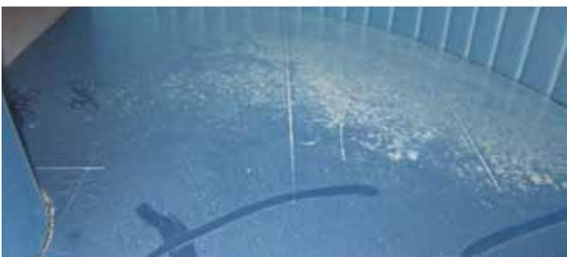
*Detalle del polvo depositado adentro de un conducto P3ductal care almacenado en la obra*
