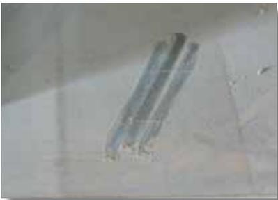
*Detalle del polvo depositado adentro de un conducto de chapa zincada almacenado en la obra*
