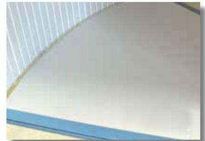
*Detalle del polvo depositado adentro de un conducto P3ductal careplus almacenado en la obra*
